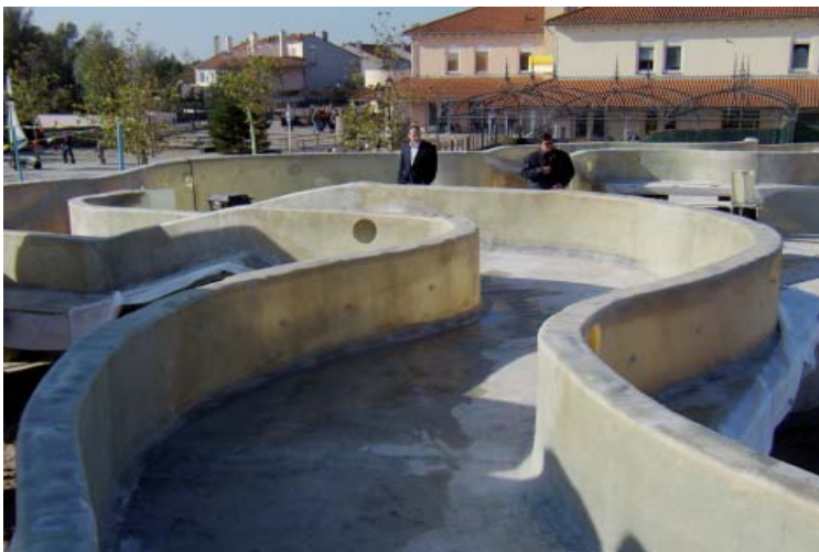
Installation Center Parcs, Port Zélande
